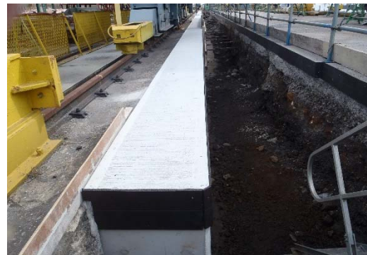
写真-6 脱枠後の出来栄
