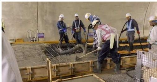
写真-3 模擬床版試験施工 (打設状況)
