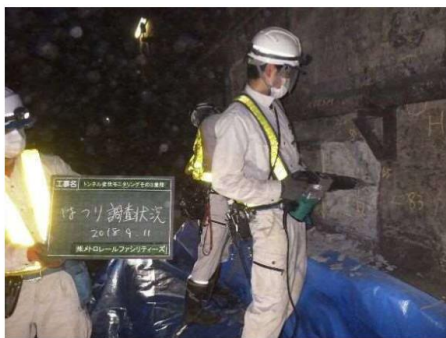
写真-3 トンネル内におけるはつり状況
