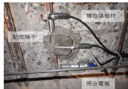
写真-2 モニタリング計測機器の設置状況
