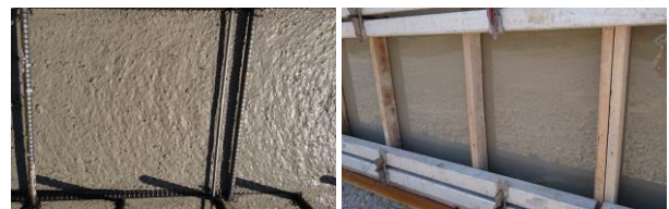
写真-5 実験後の打上がり上面(左)と側面(右)の状況
