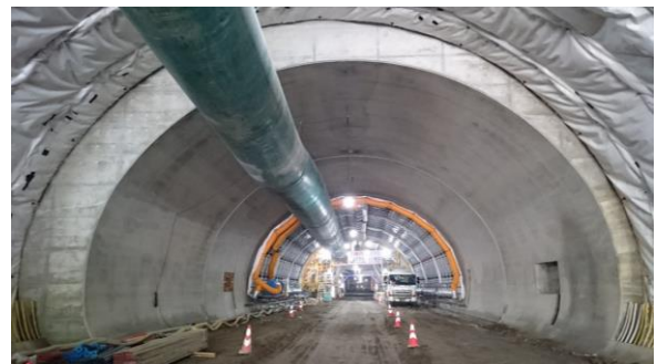
写真-8 トンネル覆工の仕上がり状況
