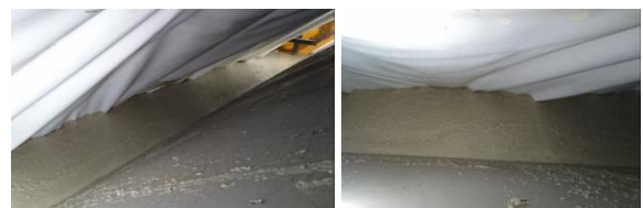
写真-7 高流動コンクリートの流動状況
