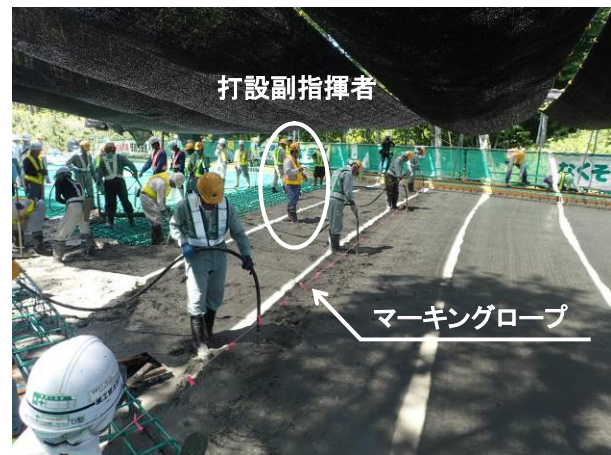
写真－4 床版コンクリート打込み状況
