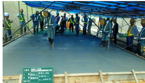
写真-1 模擬床版コンクリート打込み状況
