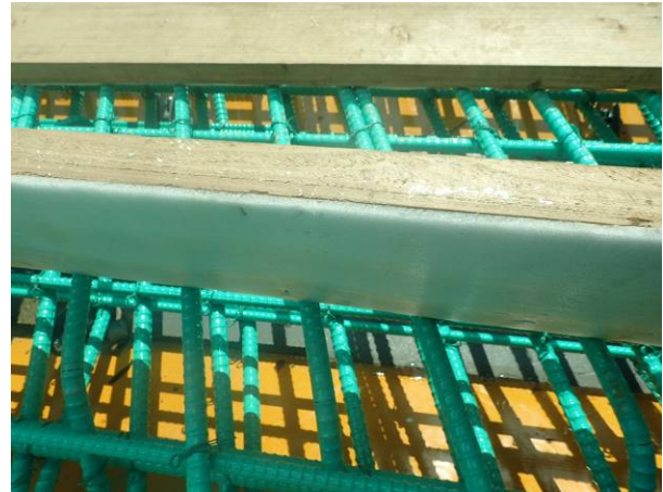
写真－3 敷板裏面にクッション材設置
