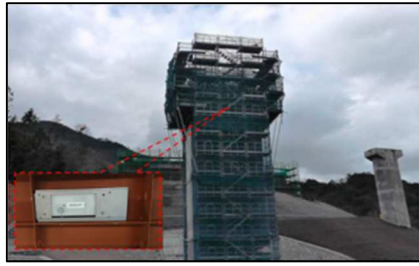
写真-1 橋梁工事現場使用（例）
