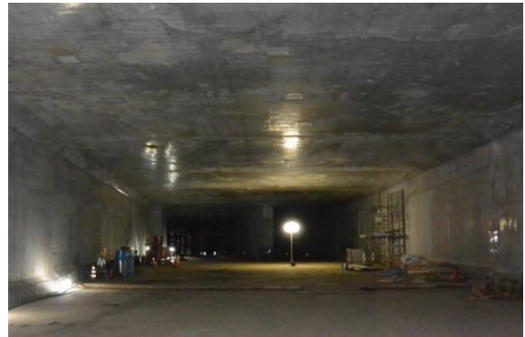
写真-7 施工後の躯体の内空状況
