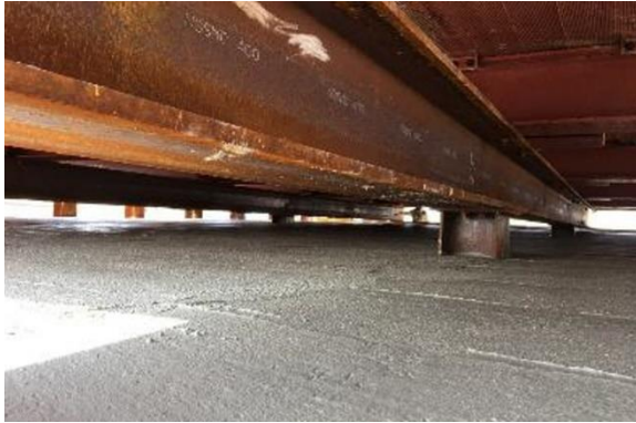
写真-5 モックアップ試験後の天端仕上り状況
