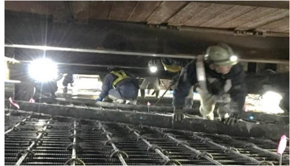
写真-6 実施工時の状況
