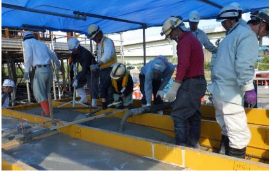
写真-4 中流動コンクリート配合選定試験状況
