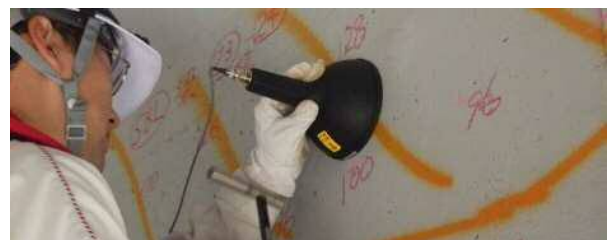
写真-6 打音法測定状況
