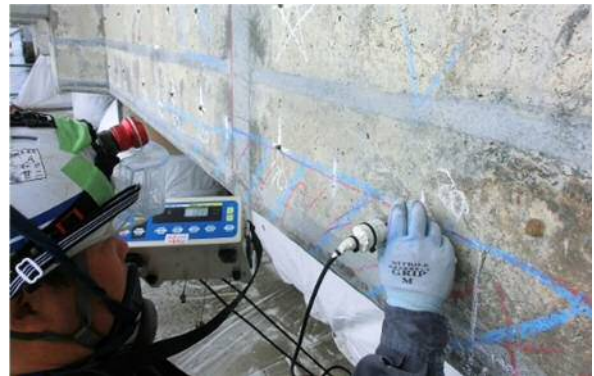
写真-2 超音波法による測定状況
