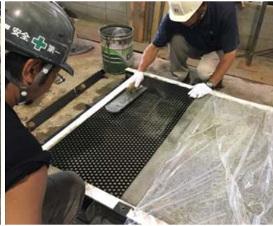
図-6 凸型付着層の形成と仕上げ
