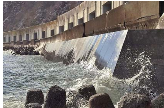
図-8 繊維補強 PFC パネルで補修した海岸擁壁
