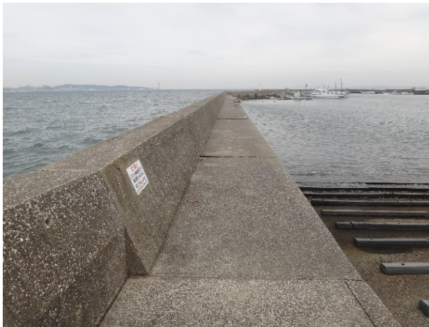
図-1 A 漁港防波堤の外観
