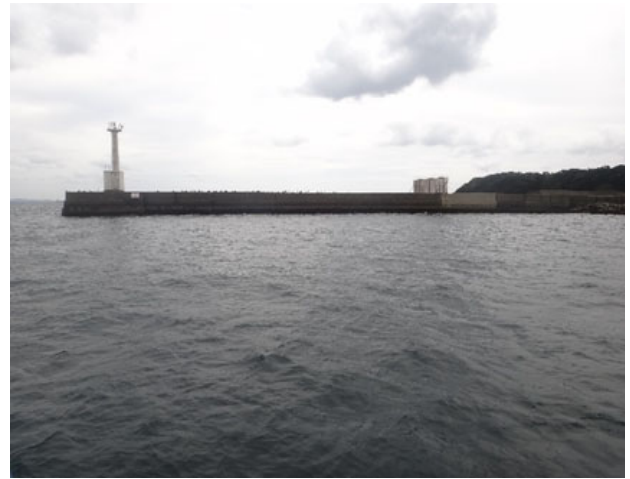
図-3 B 漁港防波堤の外観
