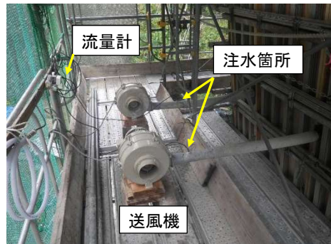
写真-3 設備設置状況
