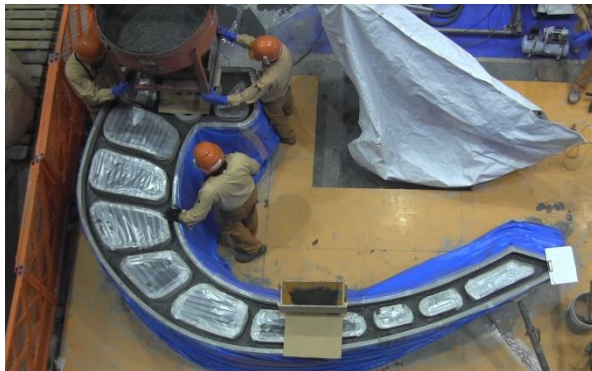
写真-10 常温硬化型 UFC 打込み状況
