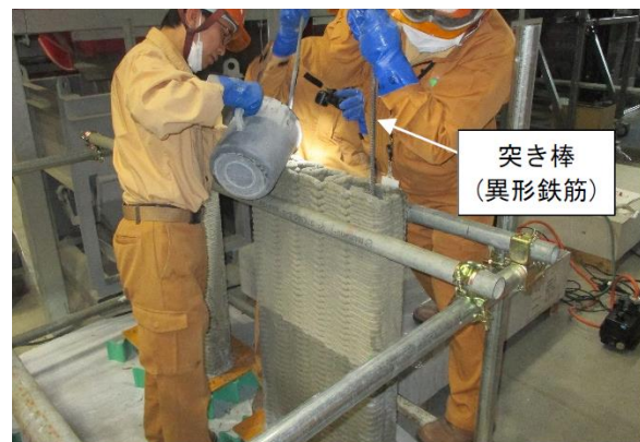
写真-5 常温硬化型UFC充填状況
