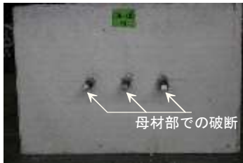
写真-3 試験終了後の試験体(母材部で破断している)
