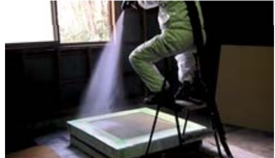
写真-2 ポリウレアの吹付状況
