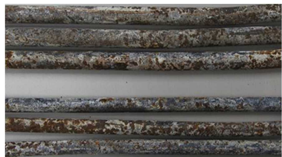
写真-1 撤去された RC 床版の鉄筋の腐食状況
