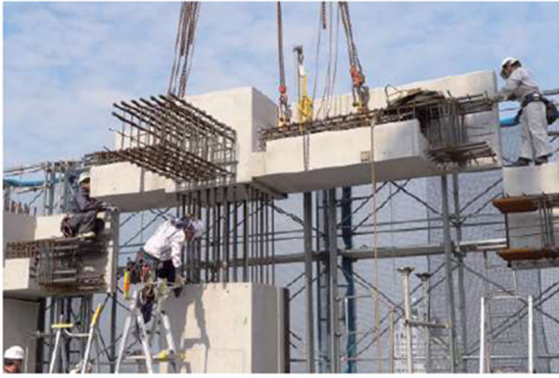
写真-2 柱梁接合部一体型のPCa部材の架設状況 1)
